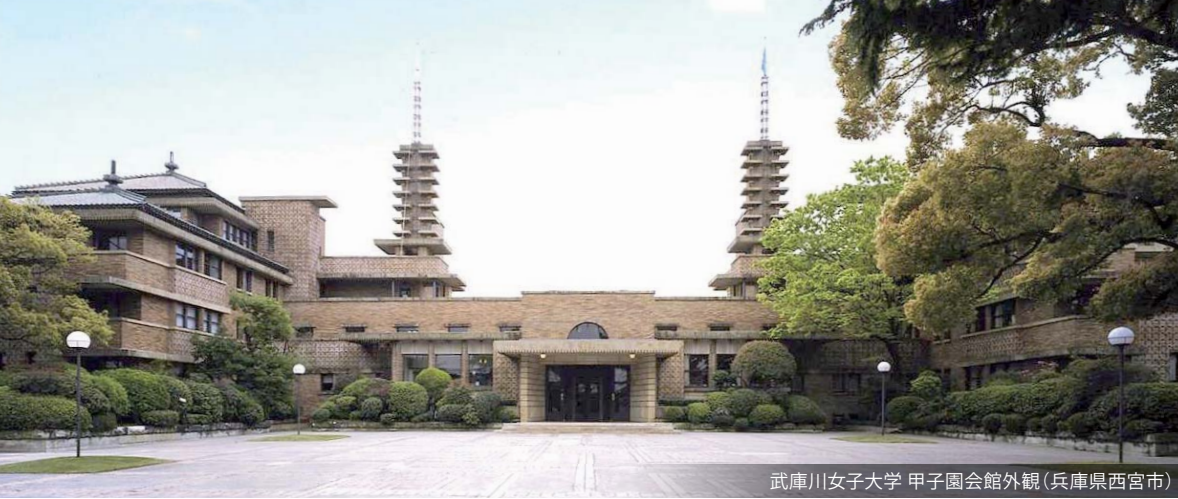
武庫川女子大学 甲子園会館外観(兵庫県西宮市)
