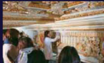
ドルマバフチェ宮殿の修復現場を見学
