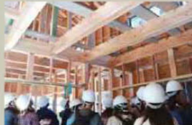
フィールドワークで木造住宅の現場を見学
