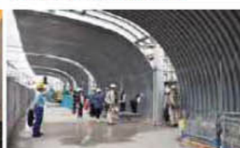
阪神電車 鳴尾駅 新築工事現場 【関連授業】建築設計実務
