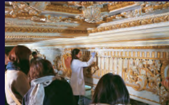
ドルマバフチェ宮殿の修復現場を見学
