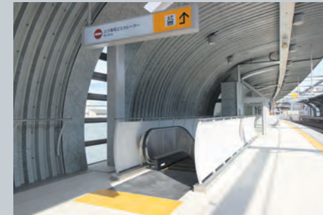
屋根に合わせて曲面の手すりをデザイン
