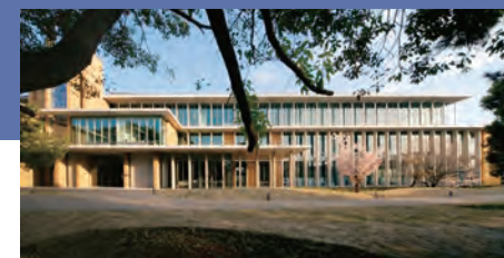
■「建築スタジオ」北側全景
