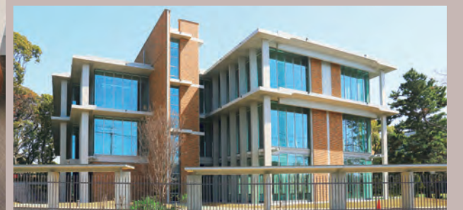
景観建築スタジオ西館 プレキャストコンクリートの新たな可能性を追求
