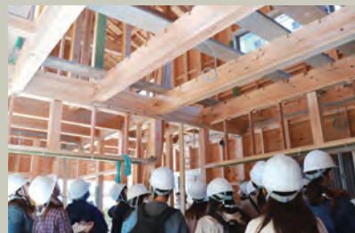
フィールドワークで木造住宅の現場を見学
