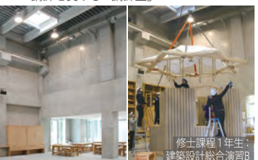
■クレーンを備えた「施工実習室」
