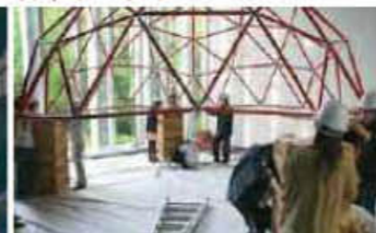
スペースフレーム組立体験 【関連授業】建築設計総合演習A
