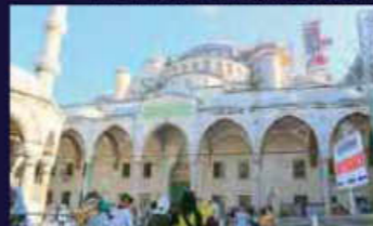
スルタンアフメットジャーミイを見学
