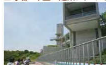
兵庫・TOTOシーウィンド淡路 【関連授業】建築設計演習III
